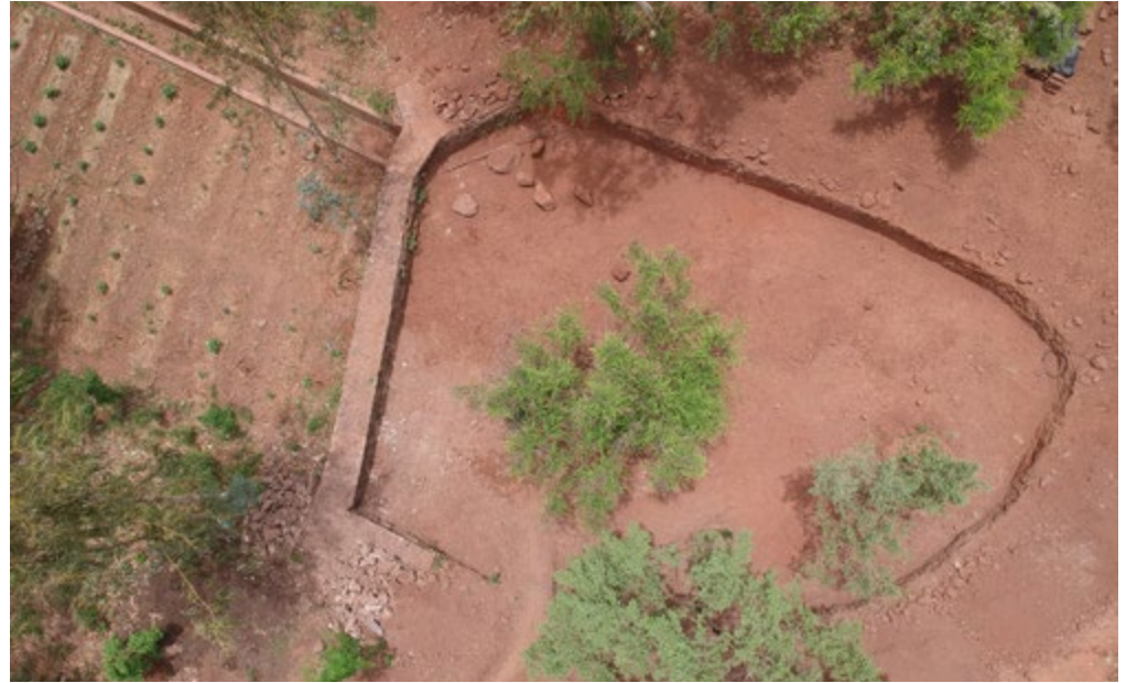
Bassin de rétention des eaux de pluies en construction
